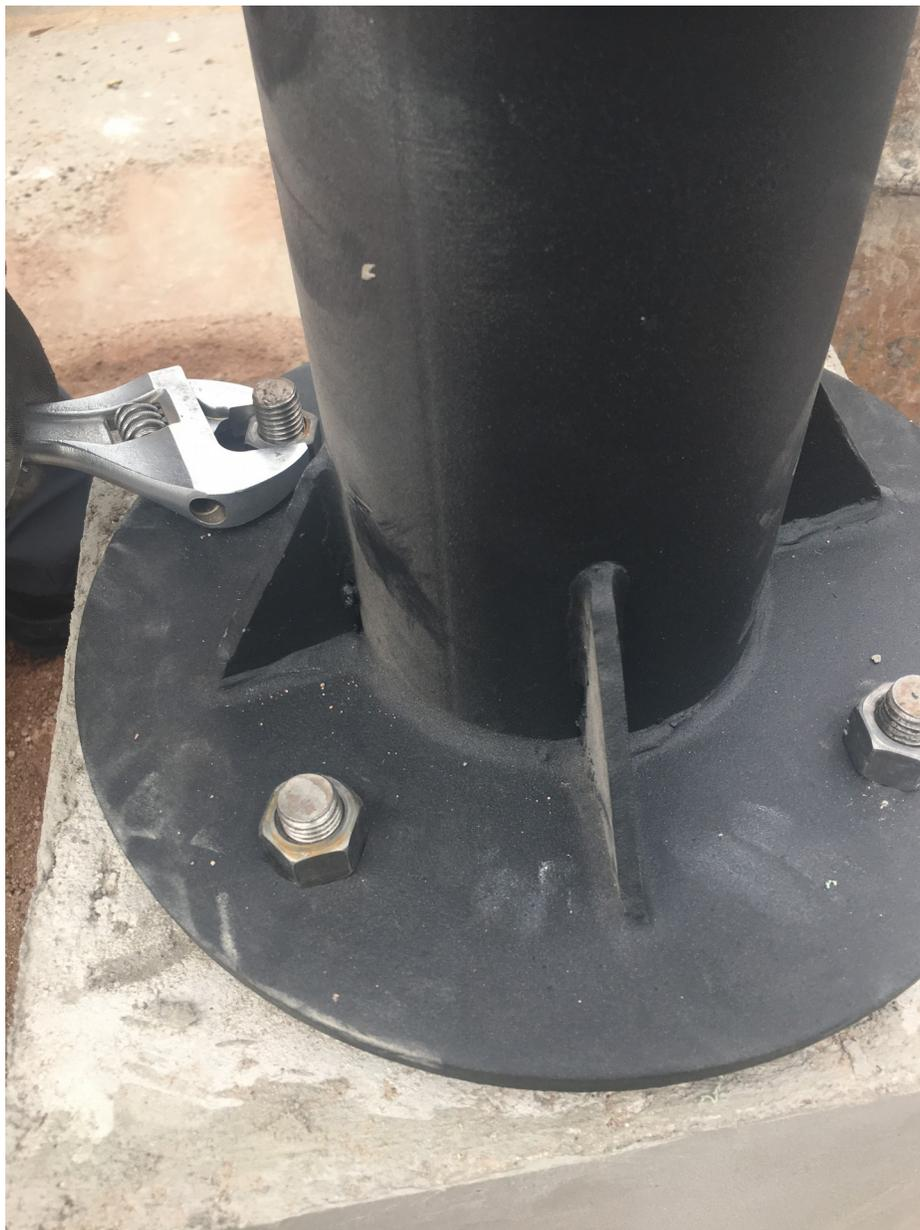
El poste esta compuesto por 5 piezas donde 2 es necesario colocarlo, la base y la punta, los otros tres postes puede prescindir de sus partes, cada una de las secciones es de 120cm de largo para lograr la altura máxima de 6 metros.
