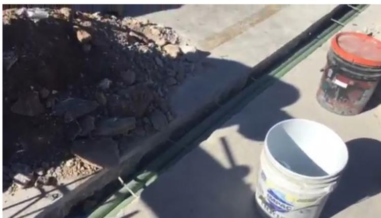
Ya cuando esta todo el ranurado con toda la tubería en el sitio, es necesario colocar la base de cimentación, para mas rigidez puede utilizar una base de varilla pero la base incluida le ayuda para sujetar con los tornillos el poste, por lo tanto no puede prescindir de esta, la instalación es recomendada en un dado de cemento, despegando del suelo al menos 30 centímetros para evitar el encharcamiento y la humedad dañe rápidamente tanto el poste como su base.
