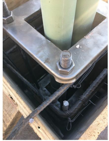
Posterior al armado de la estructura metálica se vierte la mezcla de concreto en la base.
