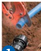
1 Corte recto de tubería
