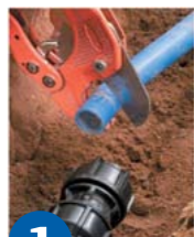
1 Corte recto de tubería
